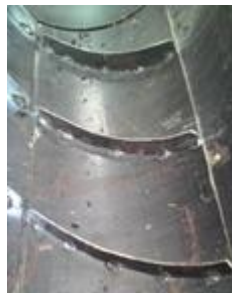
Gambar 9. Penambahan Plat Penahan pada Penutup Atas
